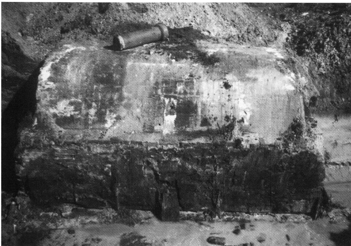
Afb. 10. De waterkelder had een diepte aan de onderkant van 2,20 m. De afmetingen buitenwerks bedroegen 3,35x1,40x1,65 m. Het steenformaat was 17x8,5x4 cm en de stenen waren gemetseld met kalkspecie en aan de binnenzijde was de kelder besmeerd met gres.
