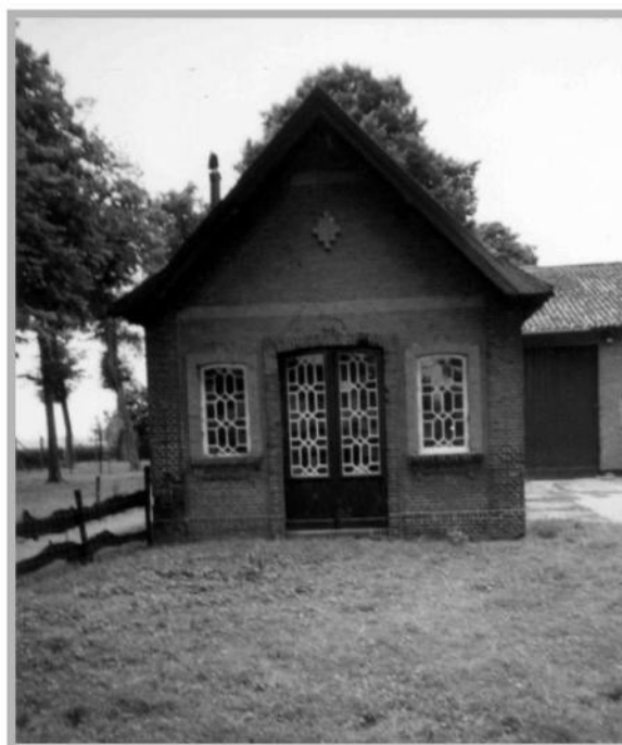
Het nog bestaande, pittoreske weeghuisje van hoeve Calfven; natuurlijk niet meer als zodanig in gebruik
