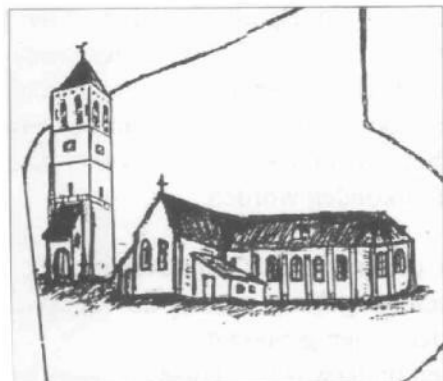
De toren kwam door brand los te staan van de rest van het kerkgebouw
