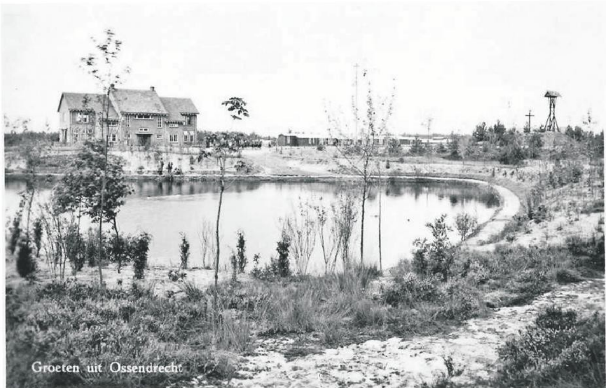
Onze Lieve Vrouw ter Duinen in de opbouwfase: let op de jongens en de barakken op de achtergrond. Het kruis rechts is nog steeds in het struikgewas aanwezig
