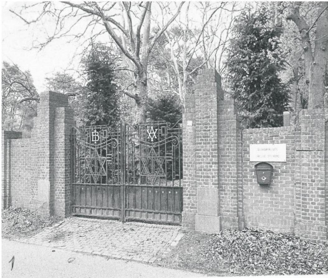
Toegangspoort tot de 1e begraafplaats van de Frechie Stichting aan de Putseweg no 36
