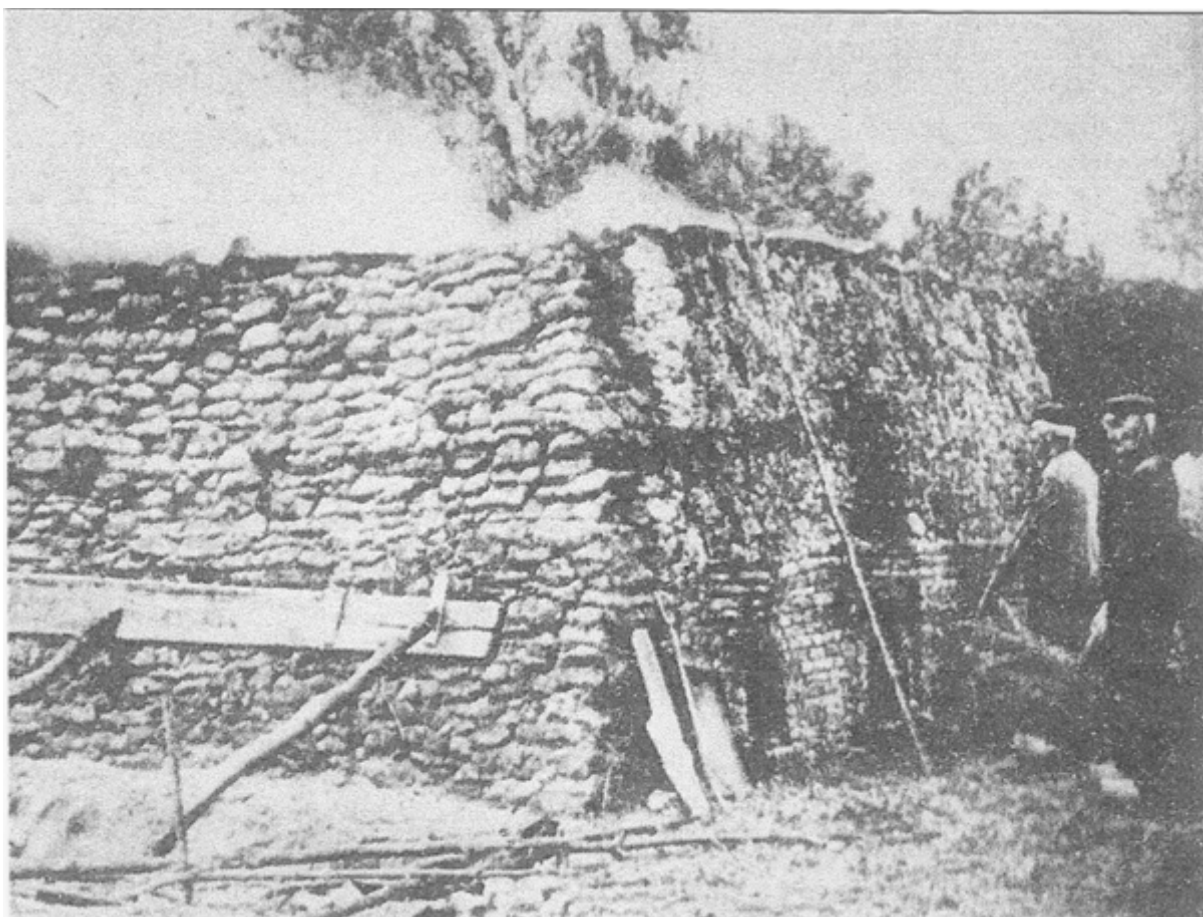
Een veldoven, zoals die overal op de Brabantse Wal voorkwamen. Hier betreft het de bakoven op De Wip in Hoogerheide van Alexander Schepers. Meer daarover in deel 2.
