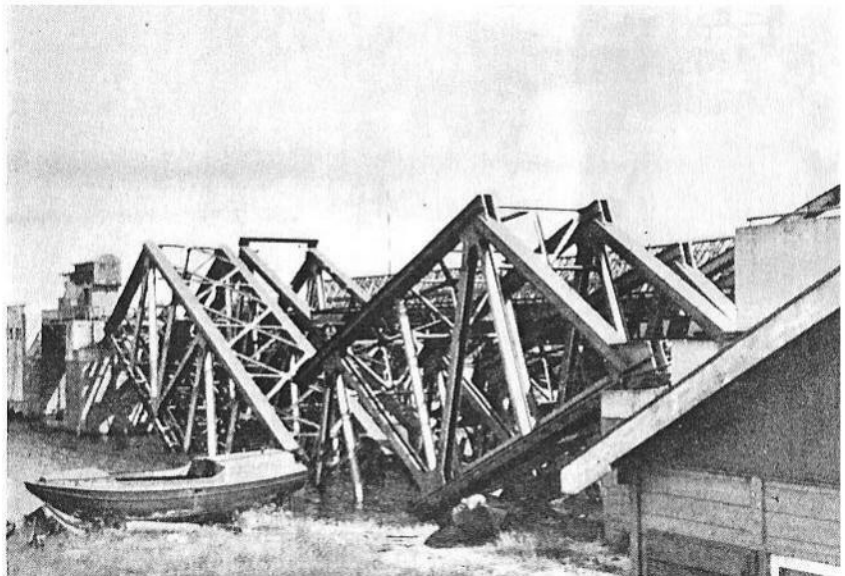
De door de vijand opgeblazen brug over het scheepvaartkanaal van Zuid-Beveland.
