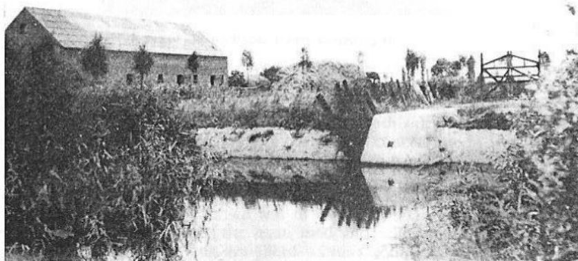
De brug over het antitank-kanaal te Stabroek, het aanvalsdoel van de D-Compagnie. In de schuur op de achtergrond van de hoeve Sijmons sneuvelden twee Duitse officieren.
