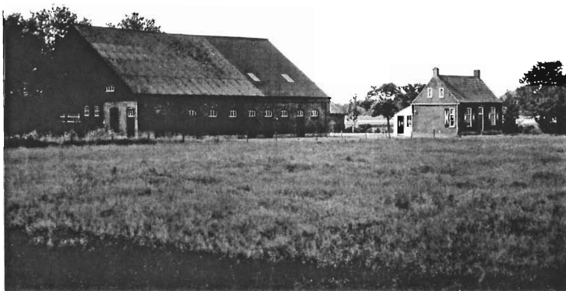
De Ambachtshoeve, gebouwd ± 1890-1900.
