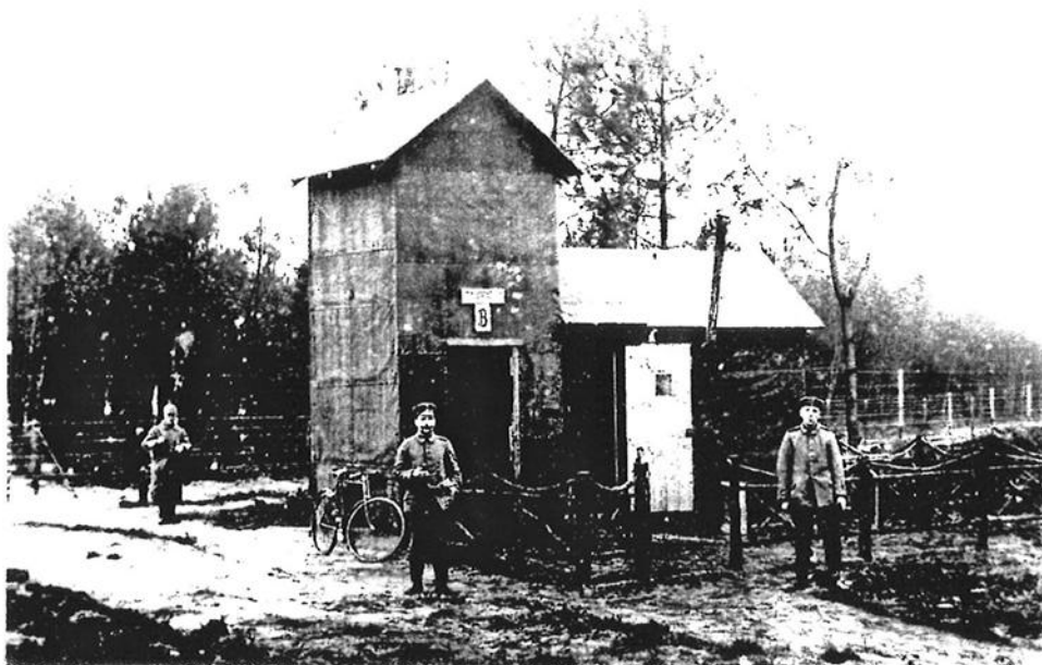
Schakelhuis H5 ter hoogte van de Klinkaardstraat te Putte. Vooraan: wachten met fiets. Rechts: draadafsluiting.
