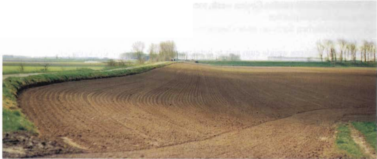
De oude zeedijk bij de Groentjeskreek. De plaats van de grote sluis. Let op de lange schuine zeezijde, dit in verband met de drassige ondergrond om meer draagvermogen aan de dijk te geven.
