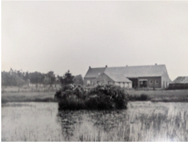
Het ven voor de boerderij dat in 1959 gedempt werd, is opnieuw aangelegd.
