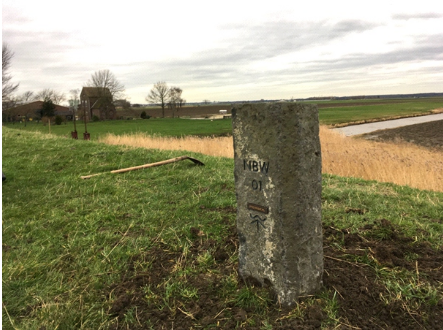
Plaatsing paal stroomgat Ossendrecht. Foto Koos Hage
