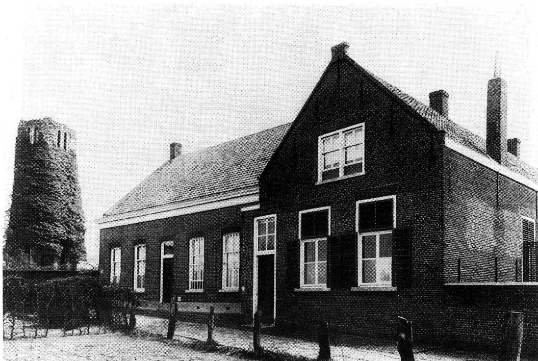
Links de Stompetoren. Aanpalend het voormalig huis van Mgr. Van mens, met aan linkerzijde het schoollokaal, naast de deur in het midden het bordje van de eerste steenlegging. Achter de getraliede vensters was de kapel van de zusters. De dwarsaanbouw is het klooster.
